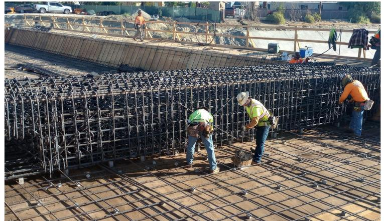
Esta foto muestra a las cuadrillas trabajando en el interior del puente. Los vástagos son las barras de refuerzo elevadas como se muestra en esta foto, y el área plana entre ellos es el plafón. Juntos, crean el interior del puente que estará cubierto por la plataforma del puente.
