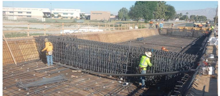
Las cuadrillas completan el trabajo de barras de refuerzo en el vástago y el plafón en el interior del tramo del puente en dirección norte/este.
