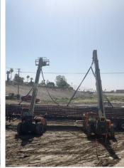
Cuadrillas que reciben el siguiente juego de envarillado de cimentación de soporte de puente. Estas columnas de refuerzo miden 5 pies por hasta 110 pies de largo y se colocarán en el suelo cerca de la carretera de circunvalación actual para eventualmente soportar el tramo nuevo del puente este en dirección norte.
