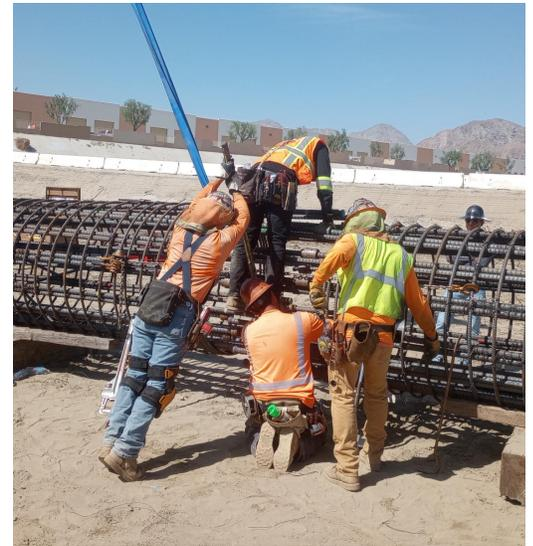
Cuadrillas trabajando en la colocación de varillas para las columnas
