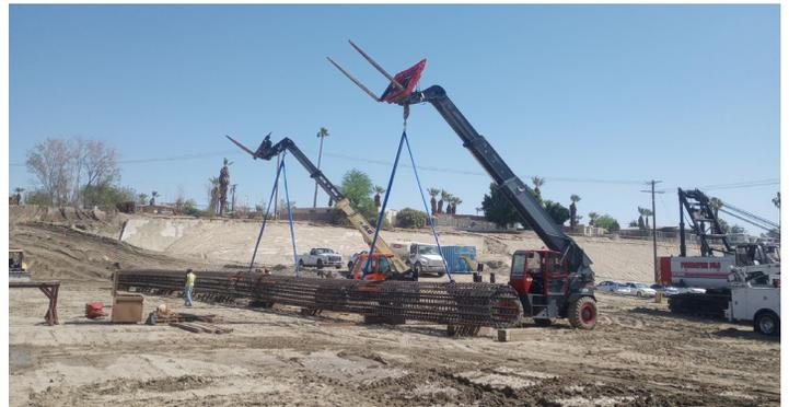
Equipo pesado movilizand los castillos para las columnas para el sistema de soporte del puente.
